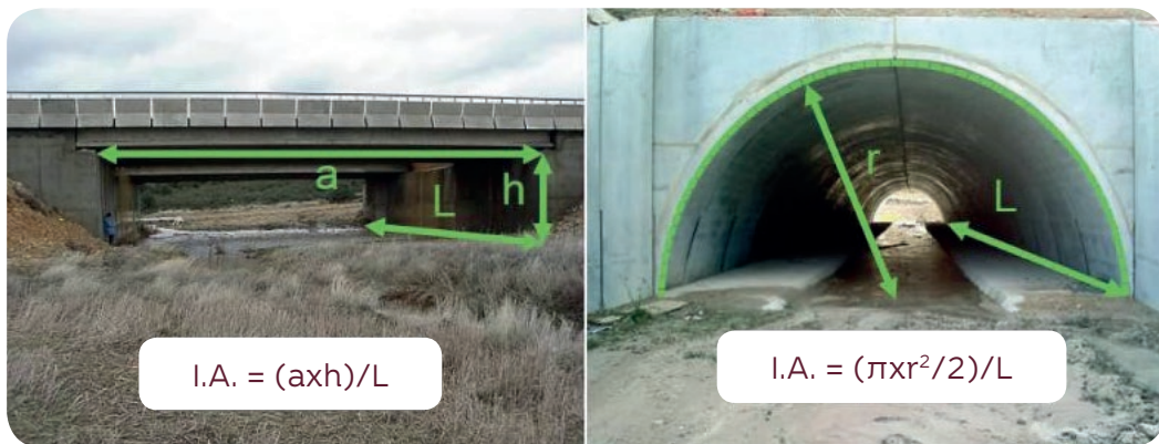
Figura 10. Índice de apertura en una estructura cuadrangular y otra de sección circular
