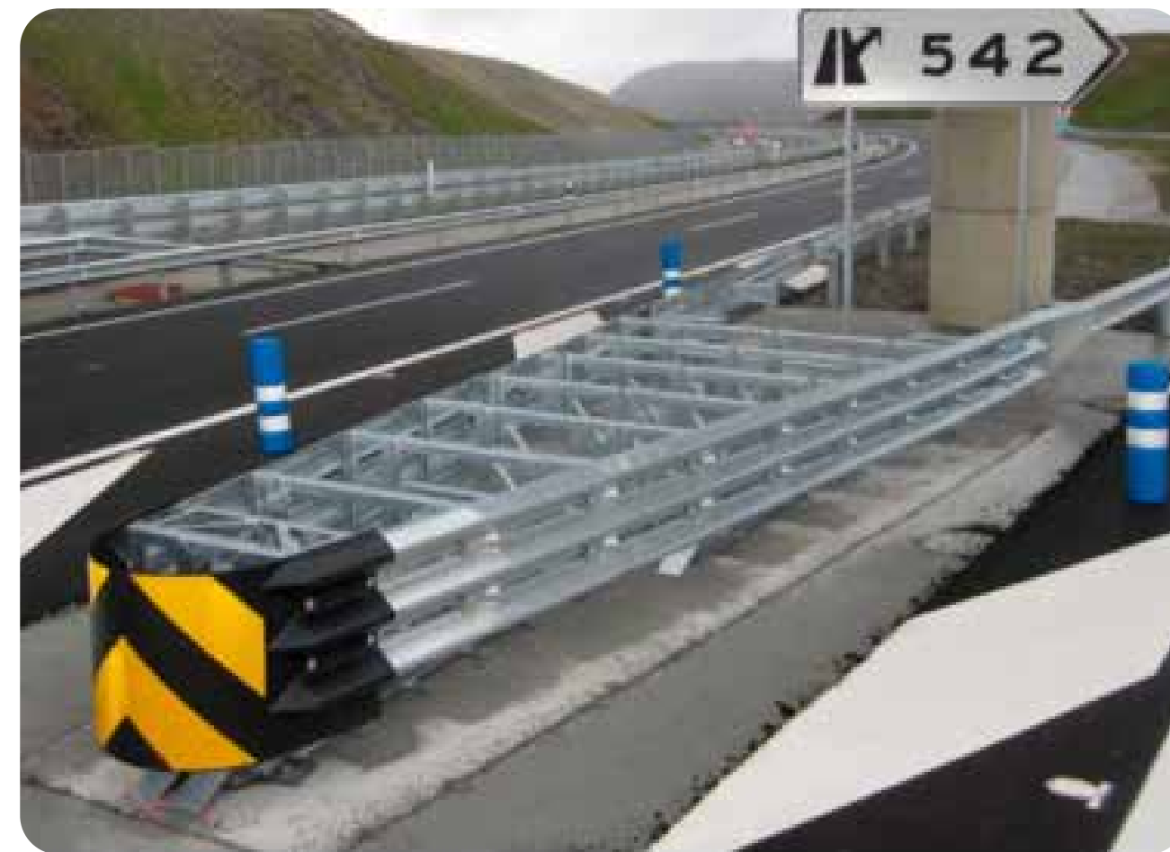
(2) Amortiguador de impacto -triangular-
