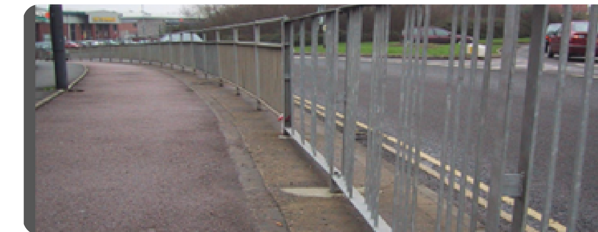
(2) Parapetos con barra escalonada que asegura visibilidad en zonas de alto tránsito, y con altura efectiva para evitar el sobrepaso
