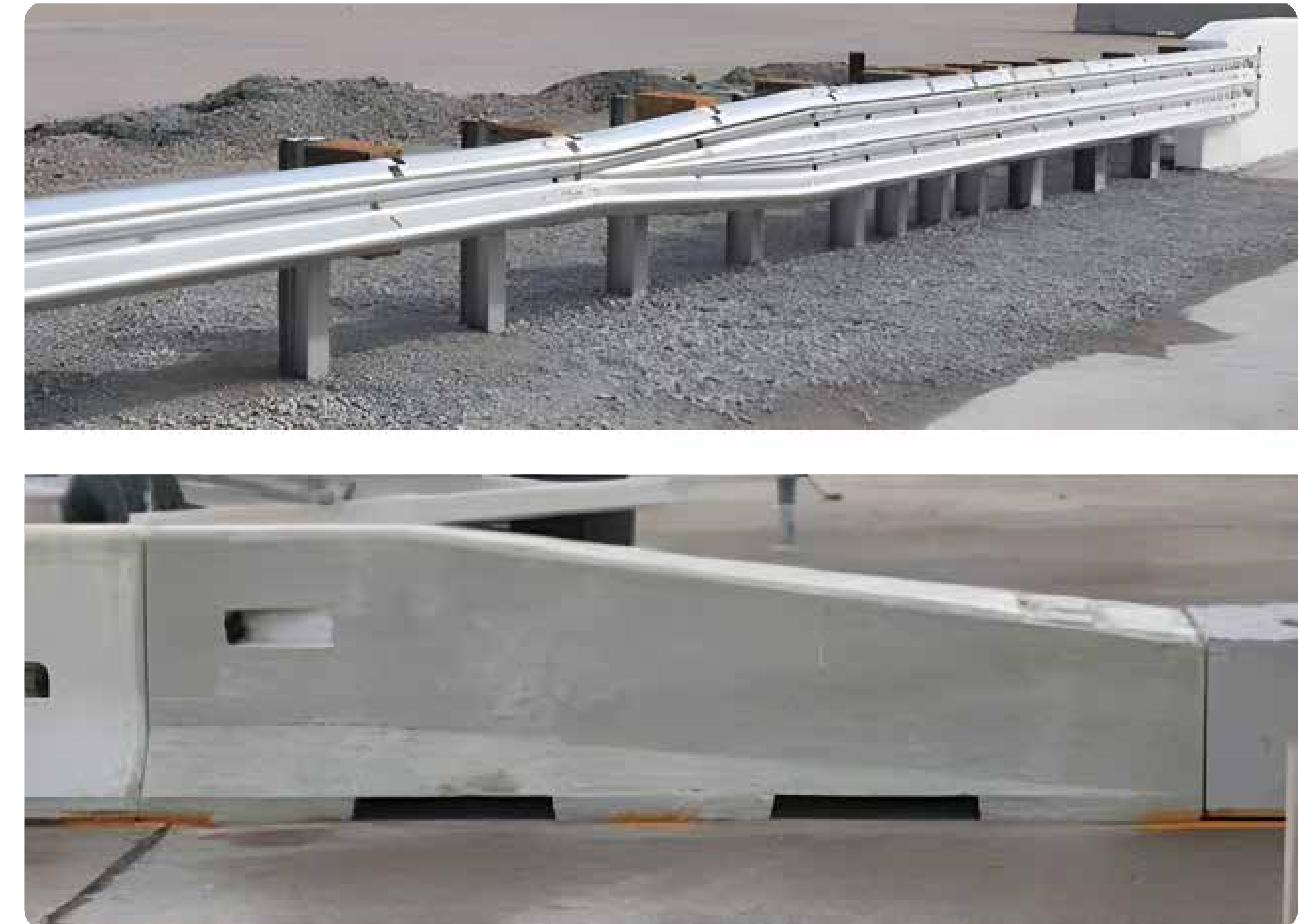
Figura 17. Transición entre barreras longitudinales
