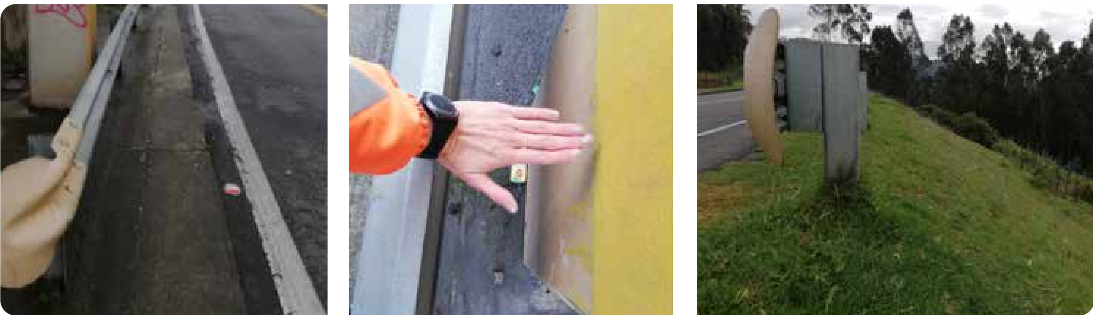
Figura 33. Fallas conceptuales en la ubicación lateral de la barrera.
