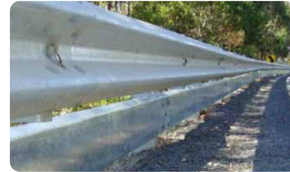
(1) Barrera semirrígida probada para protección de motociclistas
