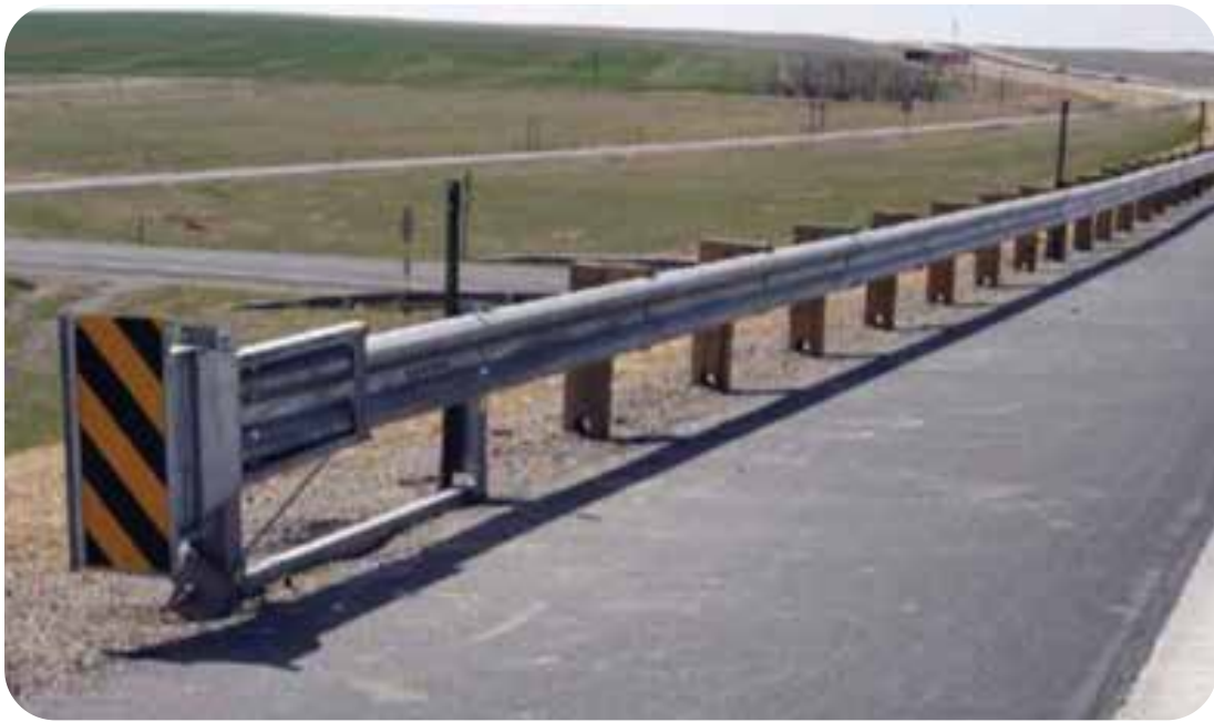
(3) Terminal Absorbente de Energía (TAE)
