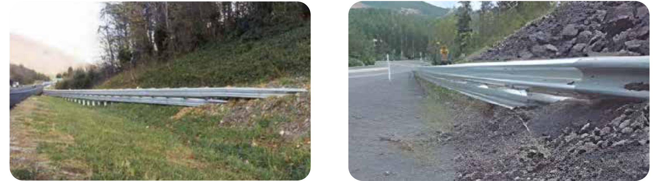
Figura 39. Terminales empotrados en talud de corte.
