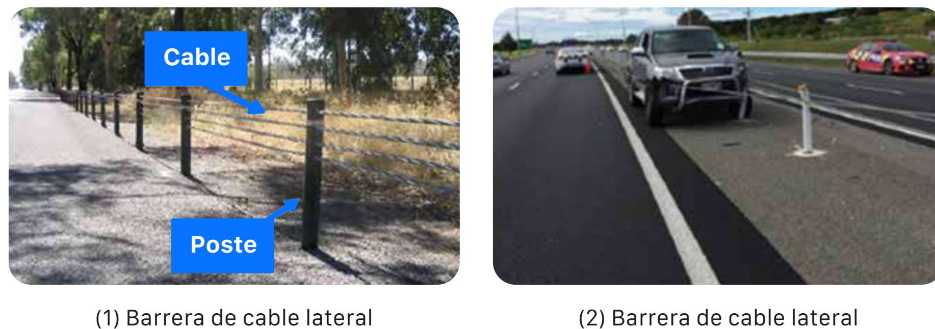
Figura 11. Partes de una barrera de cables.
