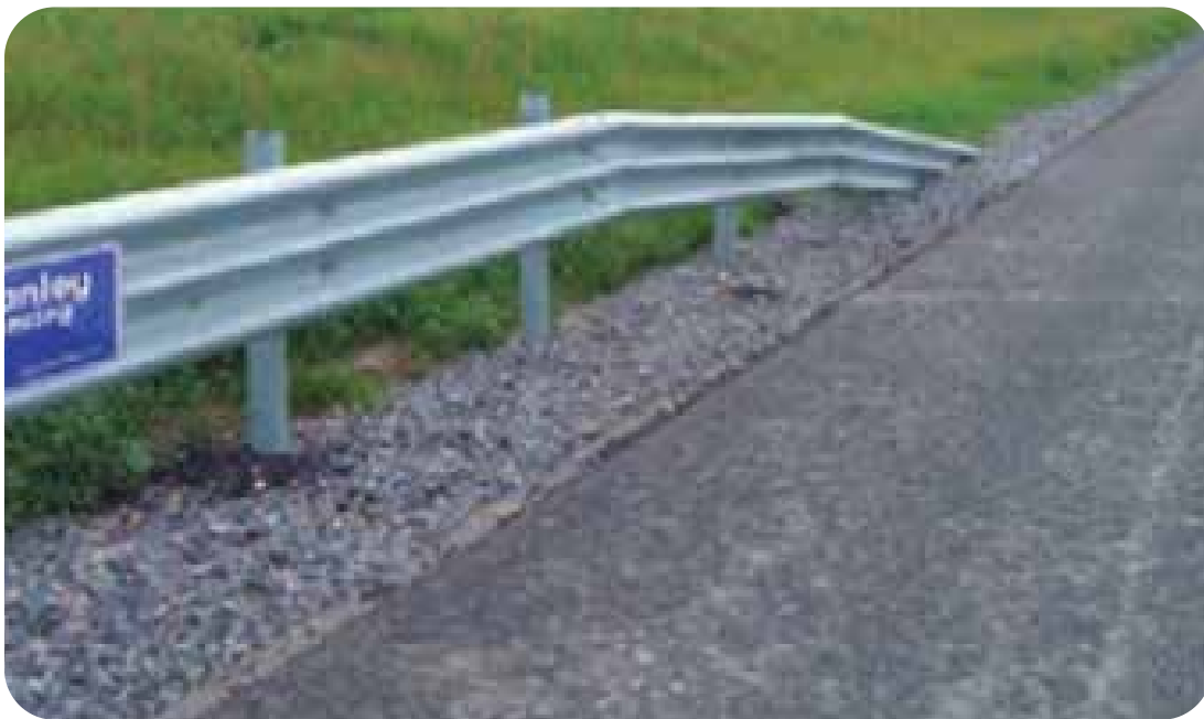
(2) Terminal abatido en barrera semirrígida
