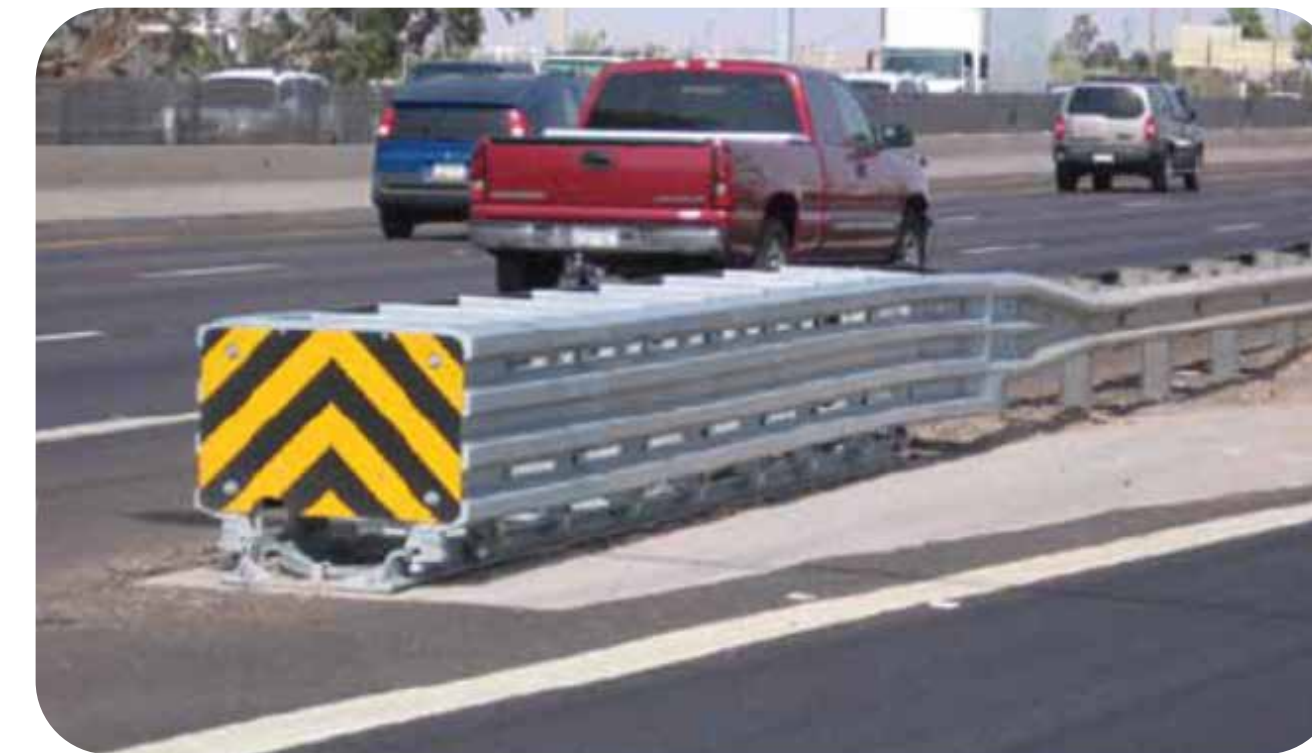
Figura 73. Amortiguador de impacto instalado en separador.
