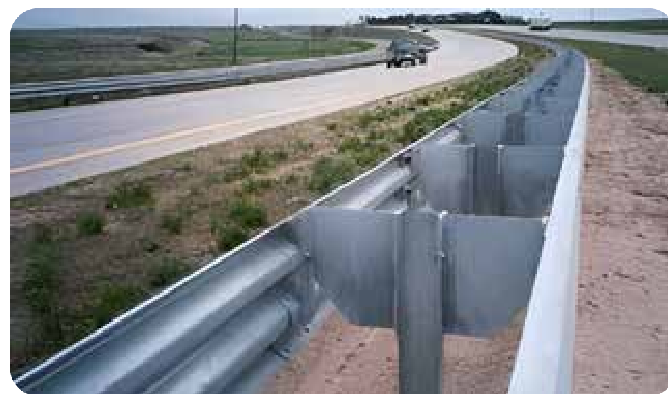
(1) Barrera metálica con separador metálico
