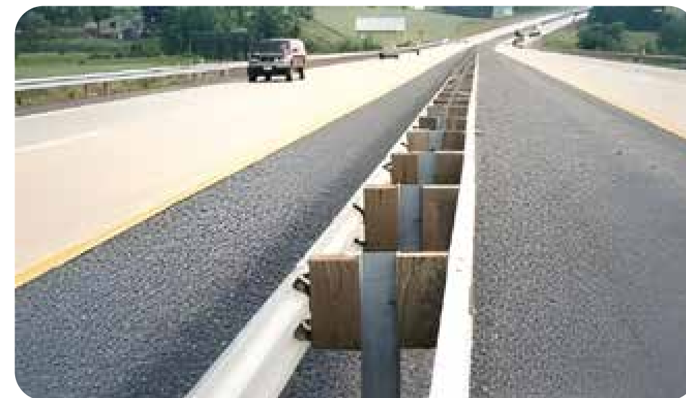
(2) Barrera metálica con separador de madera
