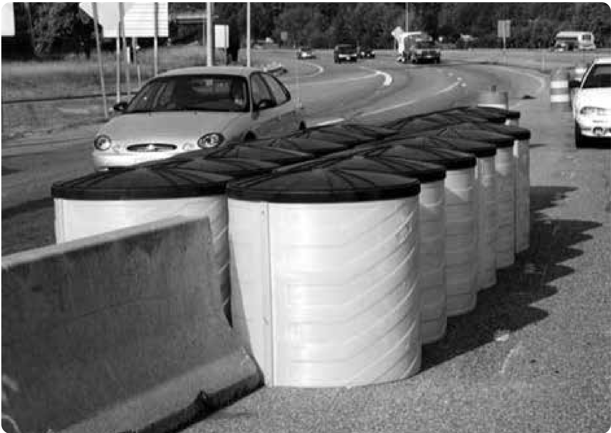
Figura 22. Sistema de amortiguadores inerciales.
