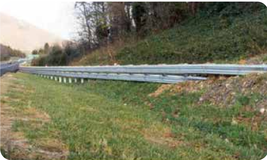
(1) Terminal empotrado en talud de corte (esviada)
