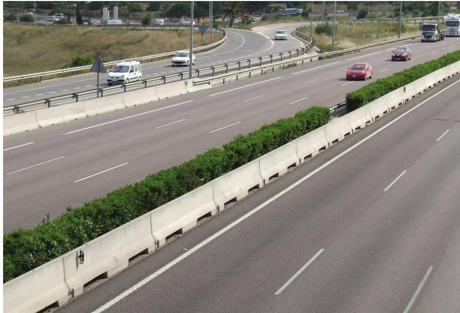
Figura 77. Barrera rígida de perfil de concreto
