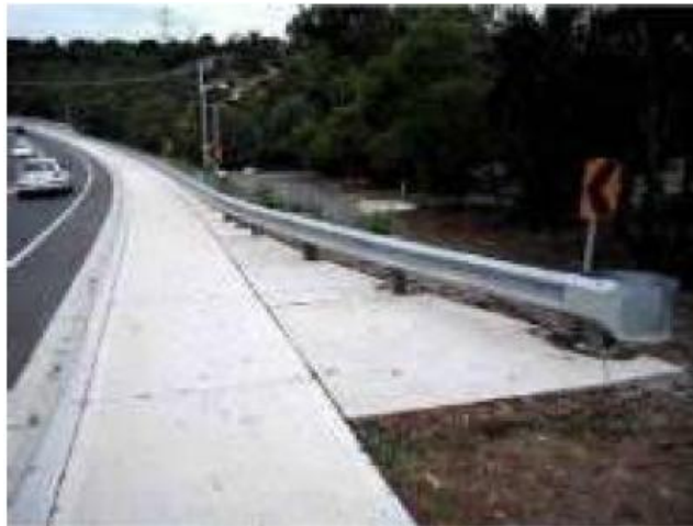
Figura 75. Terminal rompible acanalado de cable
