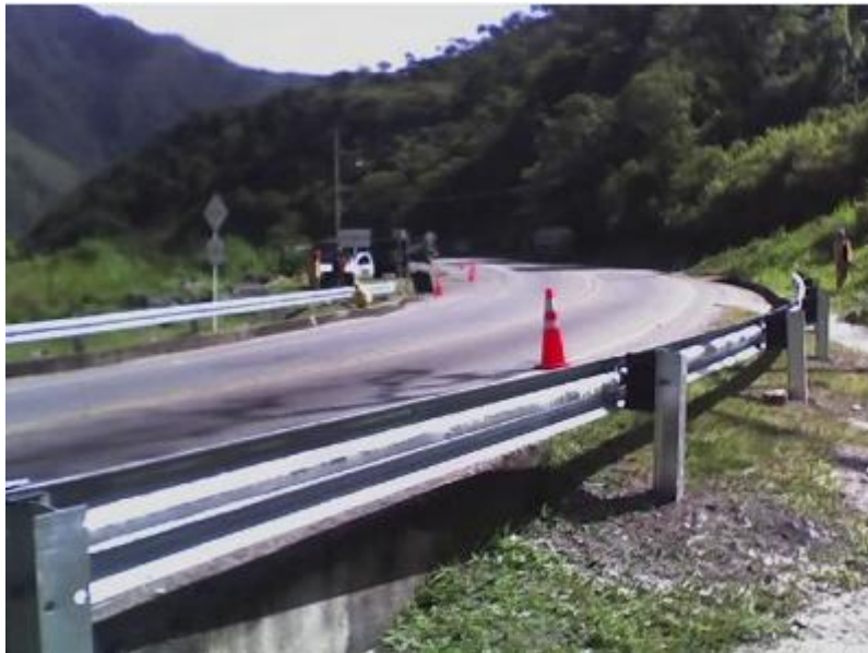
Figura 55. Defensa metálica con perfil “W”
