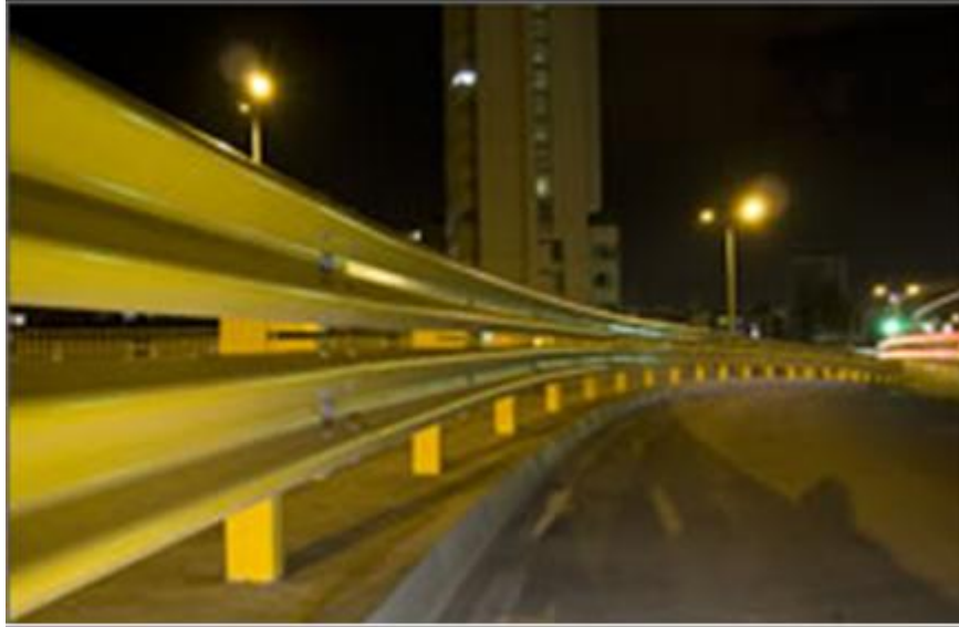
Figura 54. Defensa metálica con doble perfil W
