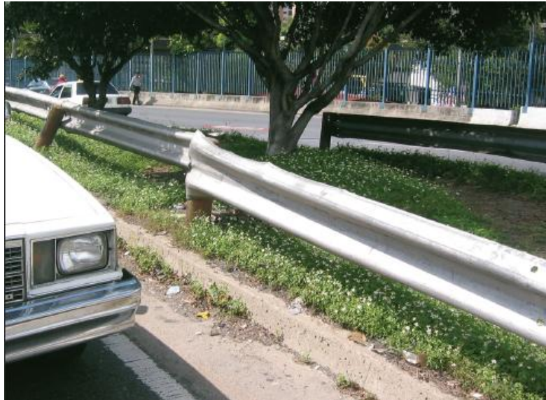
Figura 67. Defensa instalada sobre el separador central
