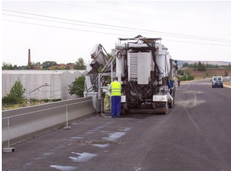
Figura 58. Detalle construcción barrera de hormigón
