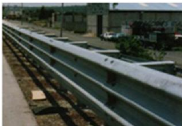
Figura 73. Barrera flexible de perfil triple onda
